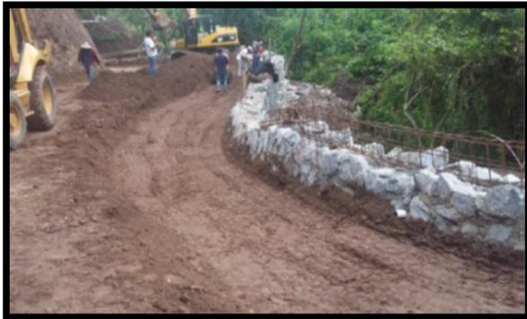
Muros de contención y coronas de muro
